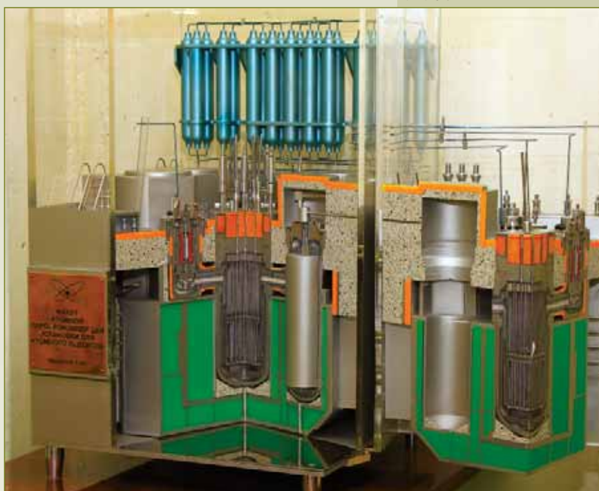
Макет атомной паропроизводительной установки АЛ "Ленин"
