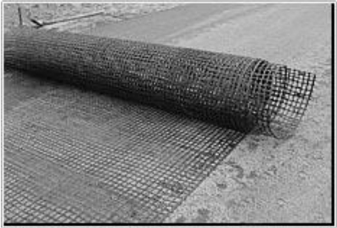
Рисунок 1. Нетканый геосинтетический материал для армирования асфальтобетонных покрытий
